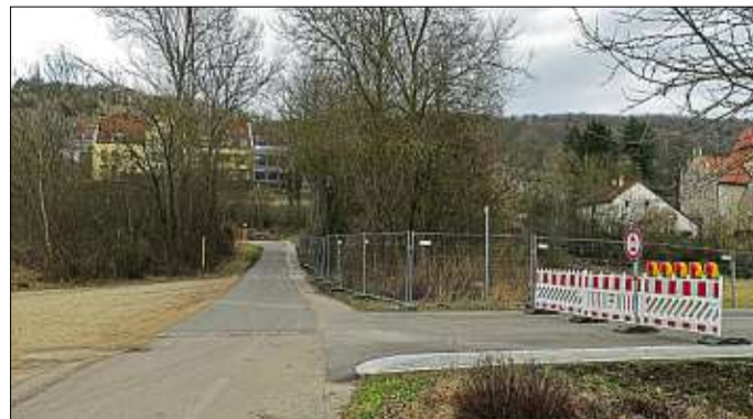
Der Durchstich vom Gewerbepark ist bereits fertig ausgebaut (rechter Bildrand), doch noch gesperrt, denn es fehlt das Teilstück hoch zur Kelheimer Straße. Foto: Kolbinger
