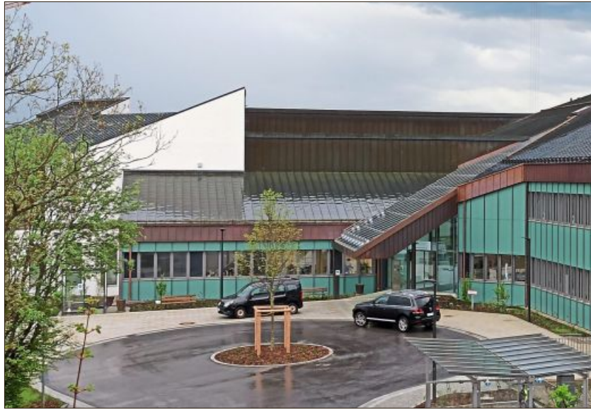
Die Arberlandklinik in Viechtach wird derzeit renoviert. So mancher Bürger befürchtet angesichts der Krankenhausreform, dass eines der beiden Häuser im Landkreis schließen muss.
