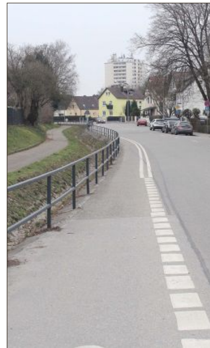
Bei der Ejadonstraße bekommt der Ziehbrückengraben mehr Platz.
